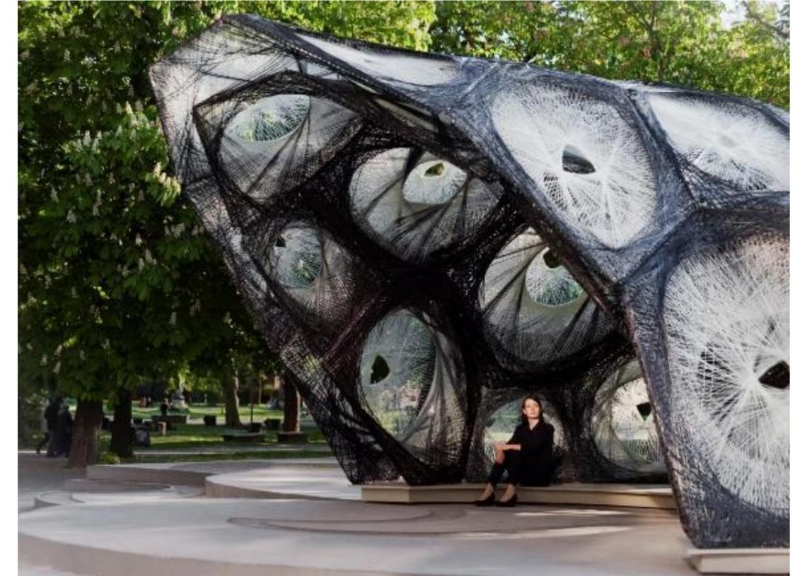
Abbildung 12: Doppelschaliger, robotisch gewickelter Pavillon inspiriert von der Morphologie des Deckflügels des Kartoffelkäfers
