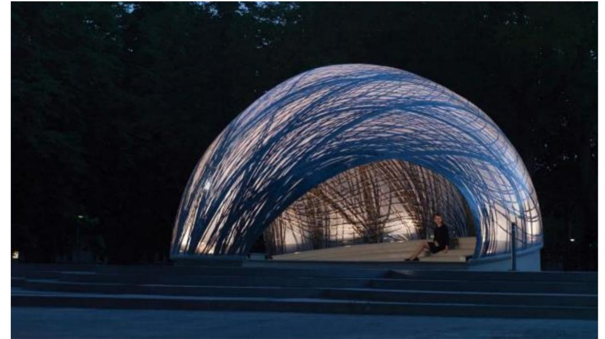
Abbildung 19: Ausdifferenzierte Faserpanordnung unter Berücksichtigung der Beanspruchungszustände
