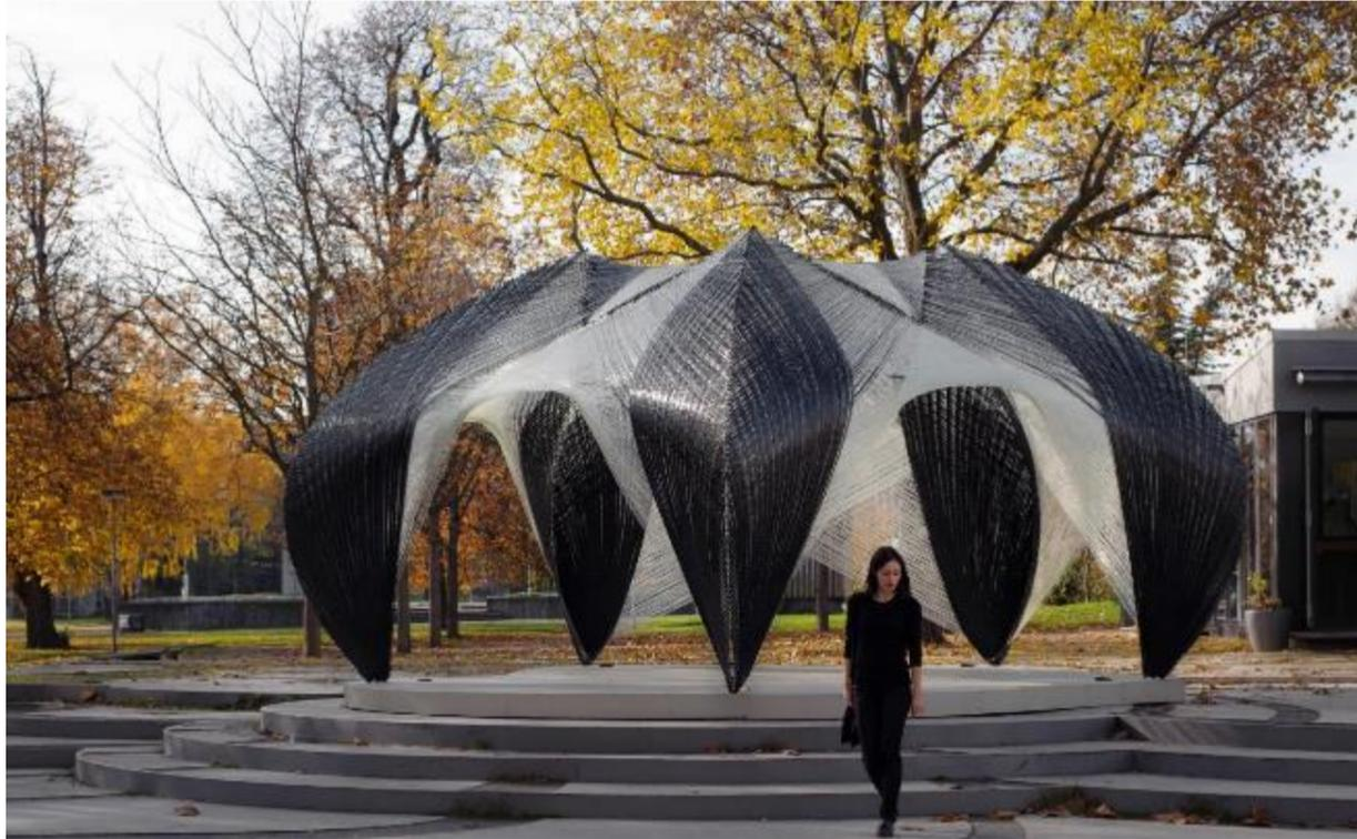
Abbildung 7: 70% des Tragwerks bestehen aus glasfaserverstärktem Epoxidharz, 30% aus Carbonfaserverstärkungen
