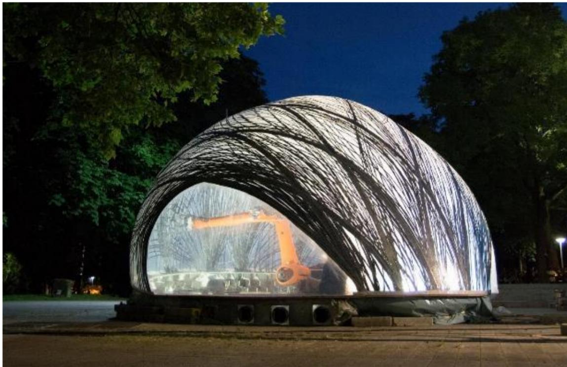
Abbildung 18: Robotisches Faserlegen auf pneumatisch gestützte ETFE-Folie
